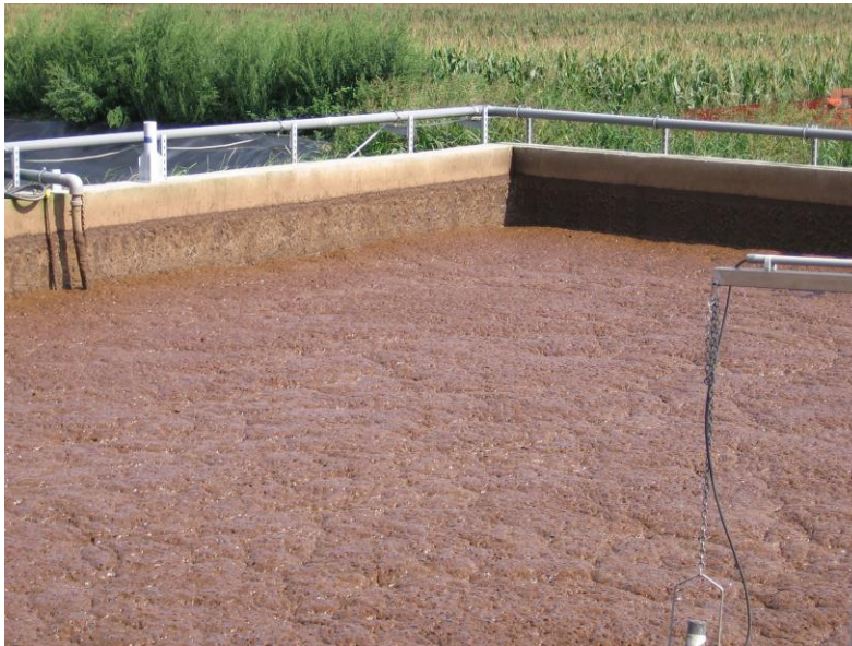
Foto: Aërobe nitrificatie
